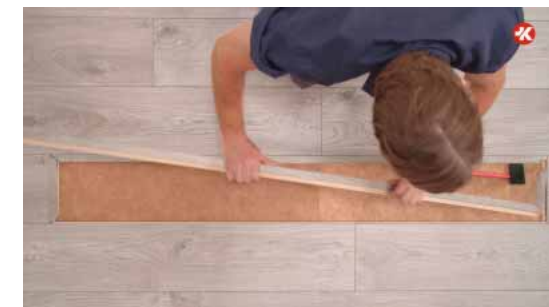
Уход и ремонт
