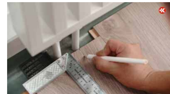
Дверные коробки и трубы отопления
