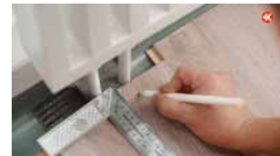
Marco de puerta y tubos de calefacción
