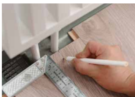
Encadrement de porte et tuyaux de chauffage
