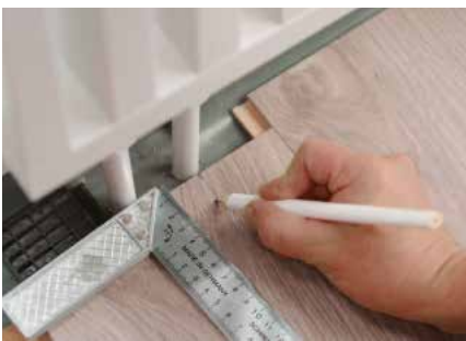
Encadrement de porte et tuyaux de chauffage
